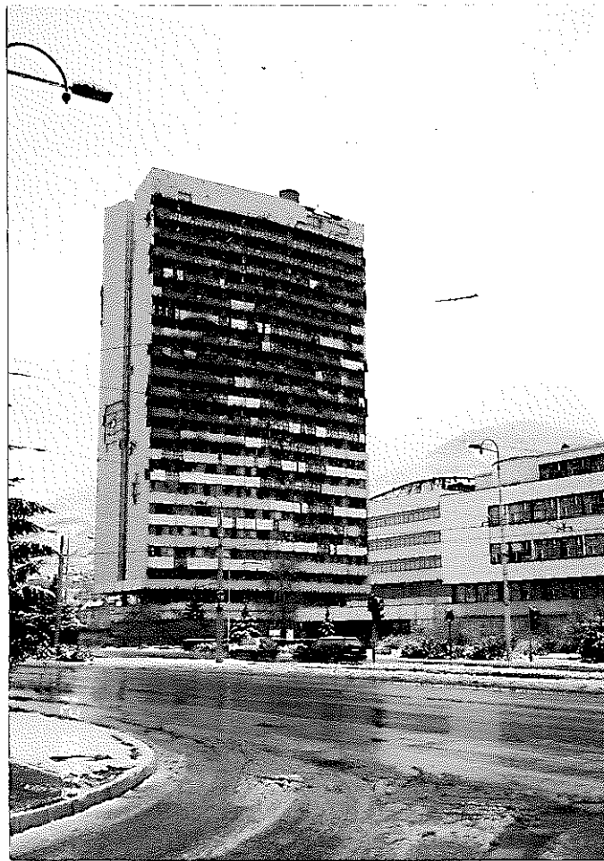
破壊されたままのサラエヴォ市内のビル
