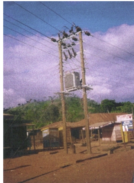
村落に建てられた電柱
