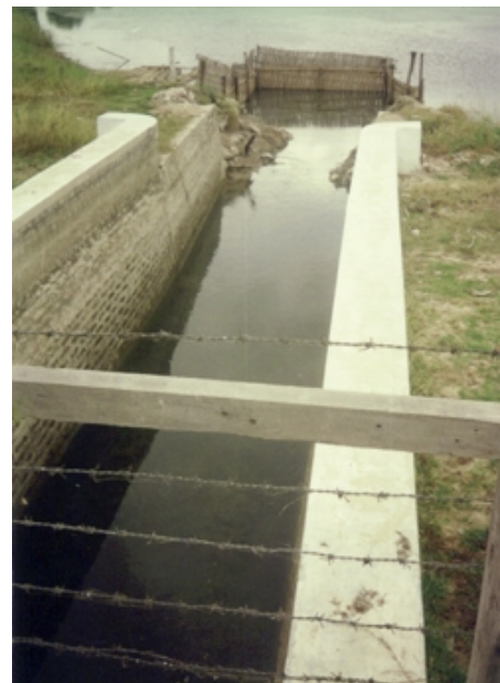
湖からの取水口
