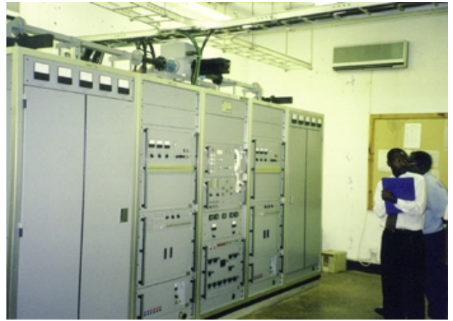
修復された監視システム
