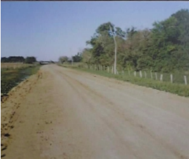
上：水を破った幹線道路 下：プロジェクトにより改善された同じ道路 (ピラール南部地域農村開発計画)
