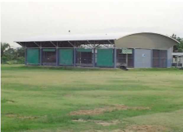
草の根無償により建設された体育館 (シリントン国立医療リハビリテーションセンター)
