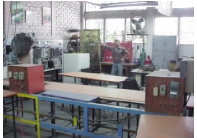
冷凍機器隊員が活動する作業場
