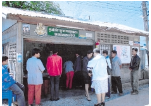
プロジェクトで建設したヘルスポスト
