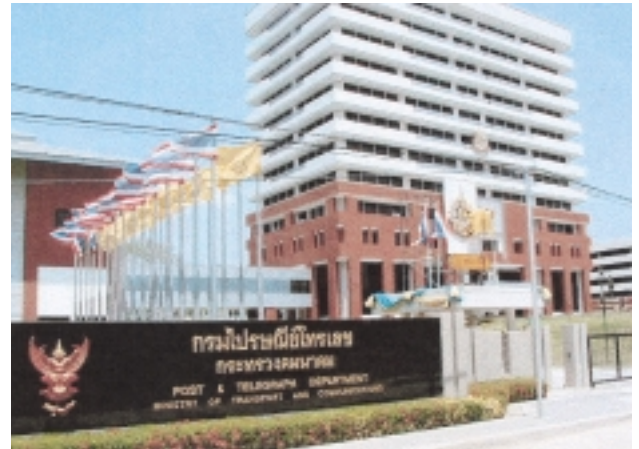
運輸省郵電総局（PID）施設外観
