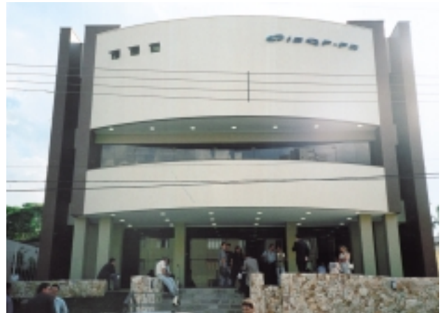
IBQP パラナの施設外観
