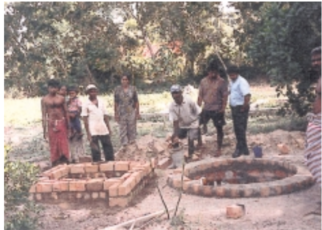
村人によるトイレの建設作業 (スリ・ランカ「参加型農村開発手法の確立」)
