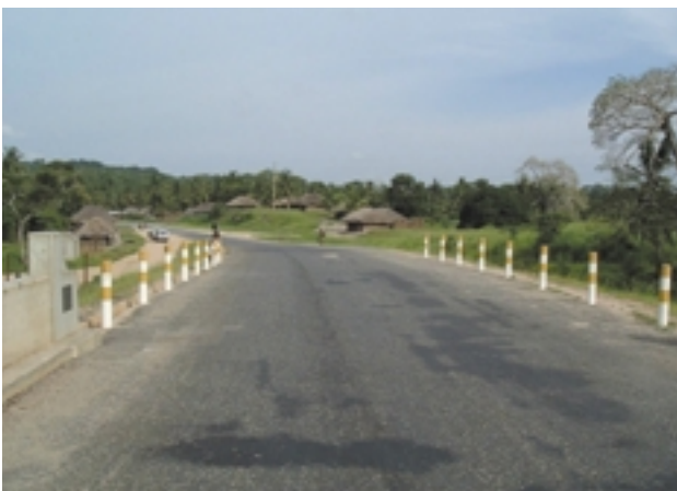
ムバブラ橋（幹線道路橋梁プログラム）
