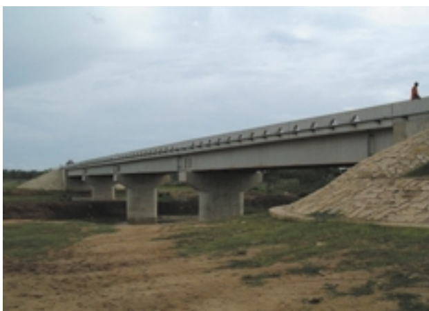
ムクワヤ橋 (幹線道路橋梁サブプログラム)
