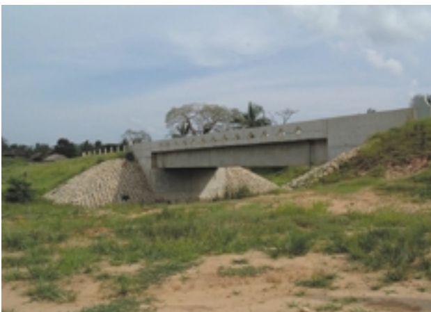
ムバブラ橋(幹線道路橋梁サブプログラム)
