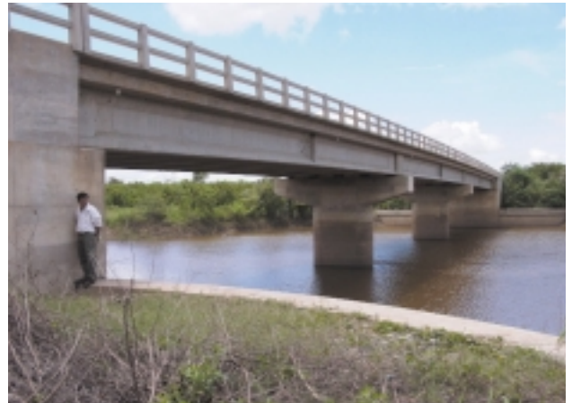
サンタクルス北部橋梁建設計画 (オキオワパイロン橋)
