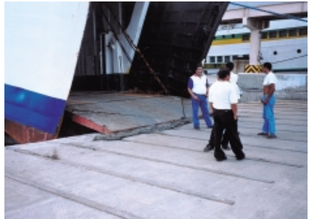
バタンガス港 Ro/Ro 船着き場の様子
