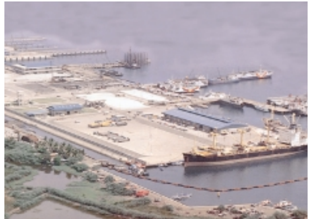
バカンダス港全景 (手前から貨物、Ro/Ro フェリー船、高速船ターミナル)
