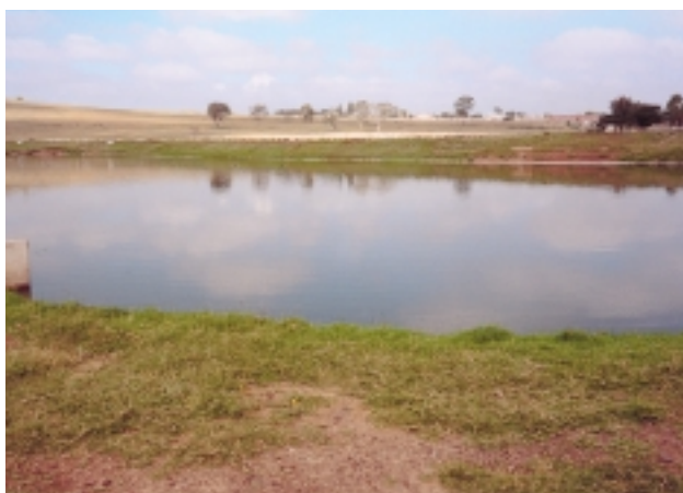
ナクル地区の汚水処理場施設
