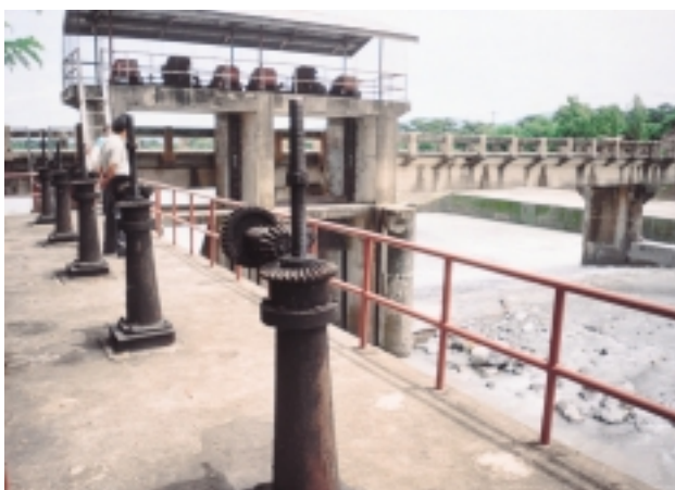
同計画フェーズ1の事業化により建設された「ソルソナ頭首工」 フィリピン「イロコスノルテ灌漑計画」
