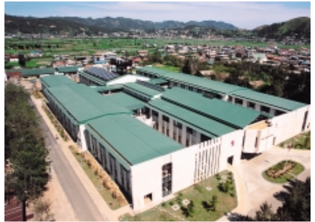
ベンゲット総合病院の外観
