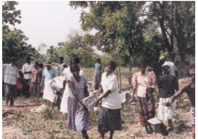
農業用貯水池の建設(村民による協力活動)
