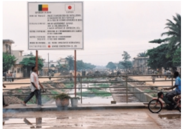
排水路の様子
