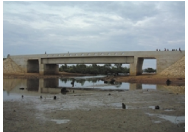
整備された幹線道路橋梁（ミキンダニ橋）
