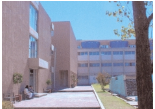
自治大学工学部の施設群(手前から2番目の建物が材料工学試験センター)
