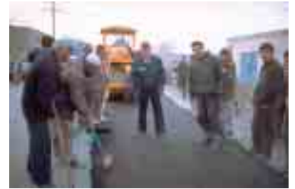
緊急復興支援調査で道路改修を進める調査団員 (アフガニスタン)
