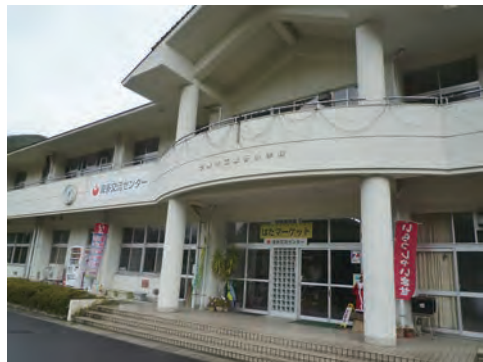
かつての小学校校舎を活用した波多交流センター
