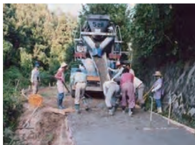
下條村での住民による道路整備
