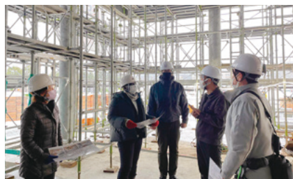
県立美術館建設現場を視察するジャマイカ研修員 (2023年1月)
