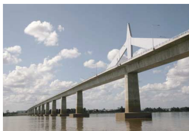
LAOS y TAILANDIA : Proyecto de construcción del segundo puente internacional del Mekong
