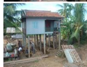
セットバック後の建物
