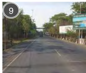
RN-17とバイパス交差付近
