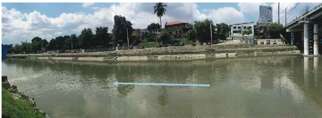
Marikina River Park 内右岸側を左岸側から望む
