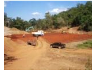
灌漑用溜池の改修 (スリランカ政府の自己予算により実施中)
