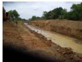
基幹水路の拡張(スリランカ政府の自己予算により実施中)
