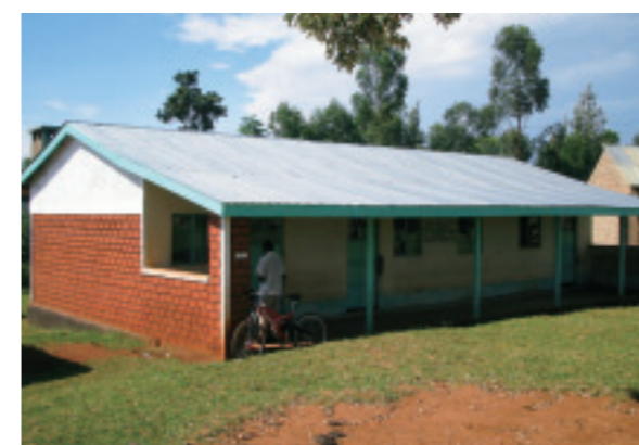
完成した簡易調理場
