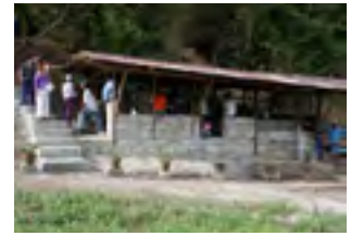
Un centro de compostaje edificado por una ONG en Ternate, Cavite
