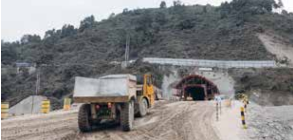
नागढुङ्गामा निर्माणाधीन सुरङ्गमार्ग
