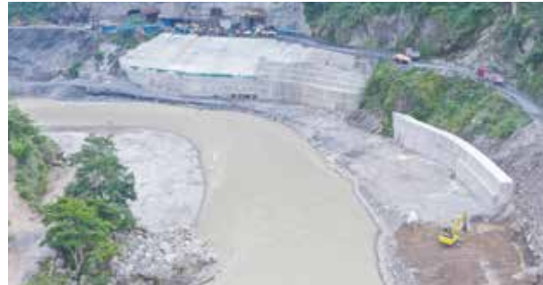
निर्माणाधीन तनहुँ जलविद्युत् आयोजना
