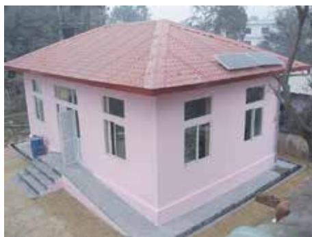
अदालतको क्षमता सुदृढीकरण कार्यक्रम अन्तर्गत धनुषा जिल्ला अदालत परिसरमा निर्माण गरिएको मेलमिलाप केन्द्र
