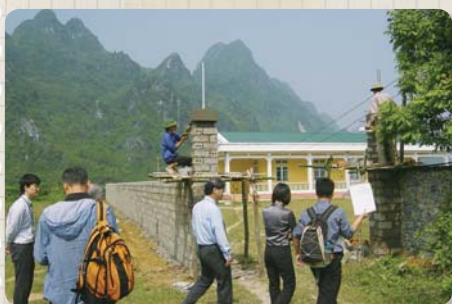
同省マイ集落にある建設中の幼稚園 背後には石灰岩の山がそびえたつ
