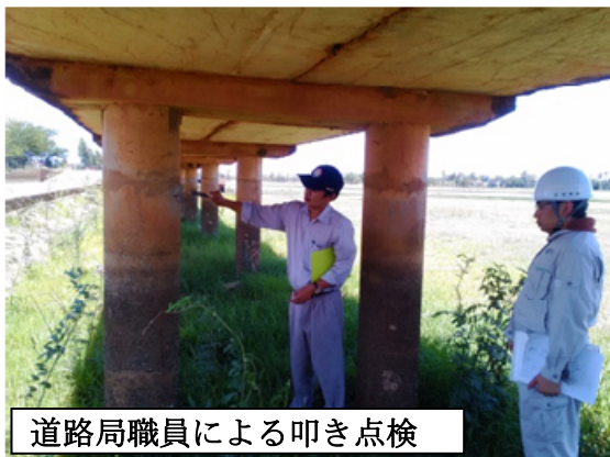
図.1 道路局職員に対する JICA 専門家による橋梁の点検の指導
