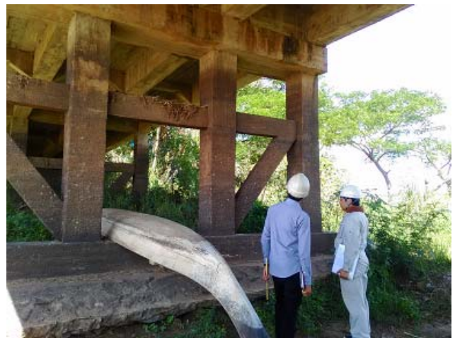
図2：橋梁調査状況
