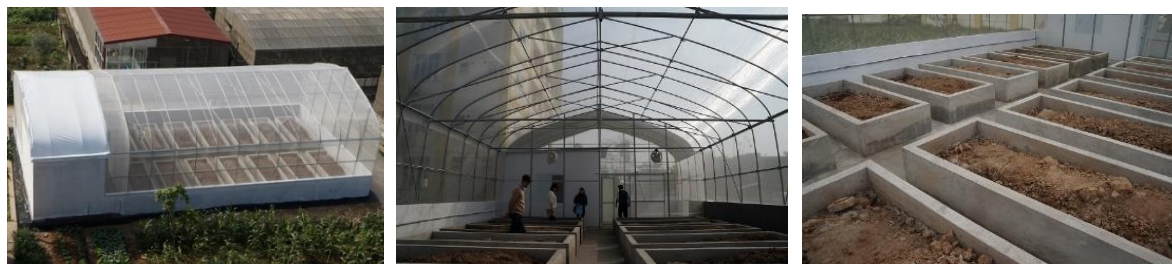
左: 完成したインセクトフリーな網室の全景、中央: 網室内部、右: 内部に作られたコンクリートの苗床
