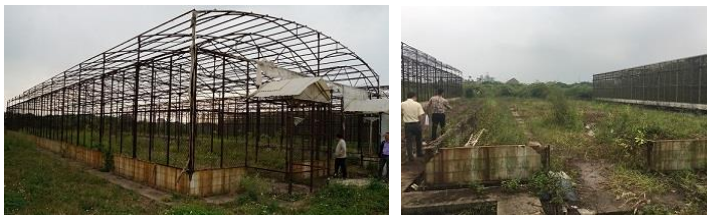
既存の老朽化した網室、既存の網室を解体撤去した
