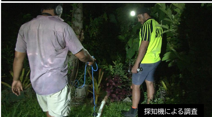
深夜漏水踏査する無収水チーム
