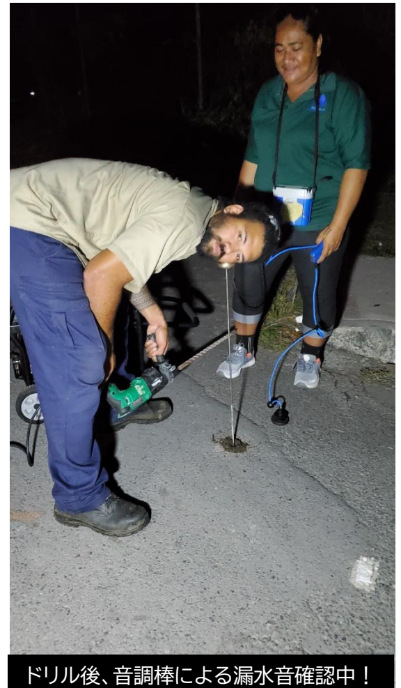
夜間漏水探知による漏水箇所の特定
