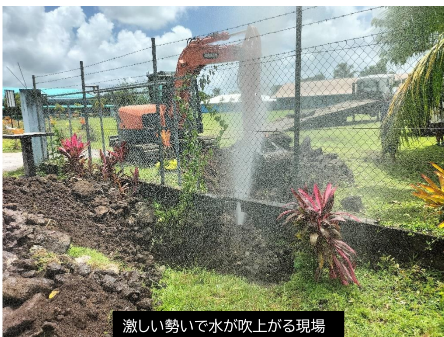
パラウリ給水区 DMA3 大型ショベルカーによる掘削現場
