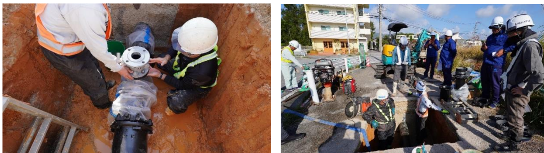
【写真キャプション】左右:宇茂佐(うむさ)地区にて消火栓管路敷設
