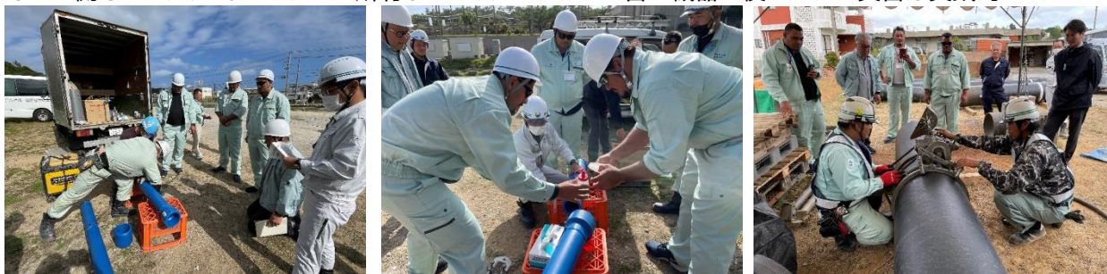
【写真キャプション】左/中:名護市久志のヤードで PE 管融着実習、右:名護市民間会社のヤードで DICP 管切断
