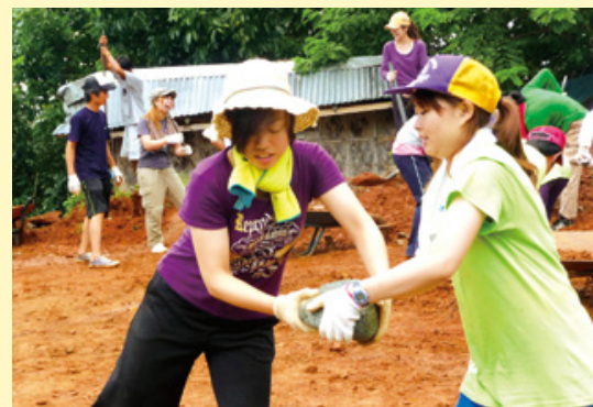
ボランティアワーク中。一つ一つの石を運んで、セメントをこねて、「子どもの家」の石垣をつくる。(CFFフィリピン「子どもの家」敷地内)
