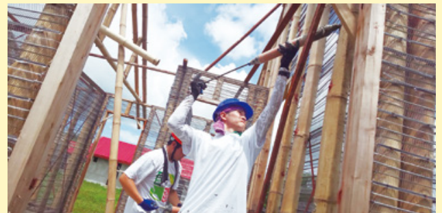
大工による指導のもと、ボランティアが竹を使った家づくりに取り組む(Silay)
