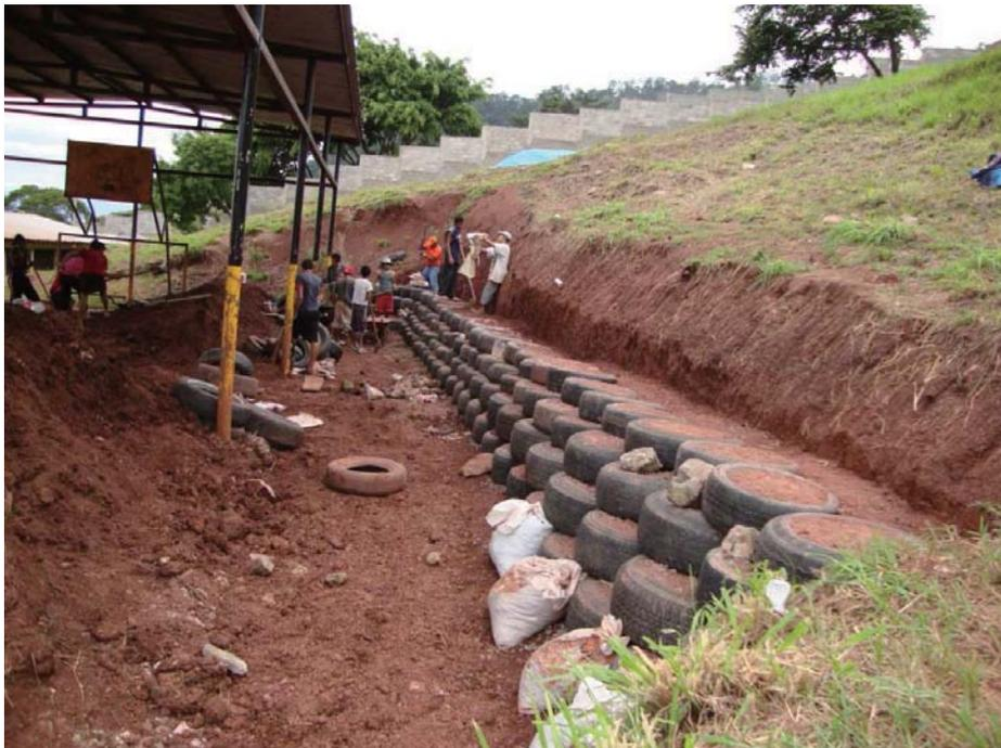
Fotografía.— 4 Finalización de la colocación del cuarto nivel de llantas.
