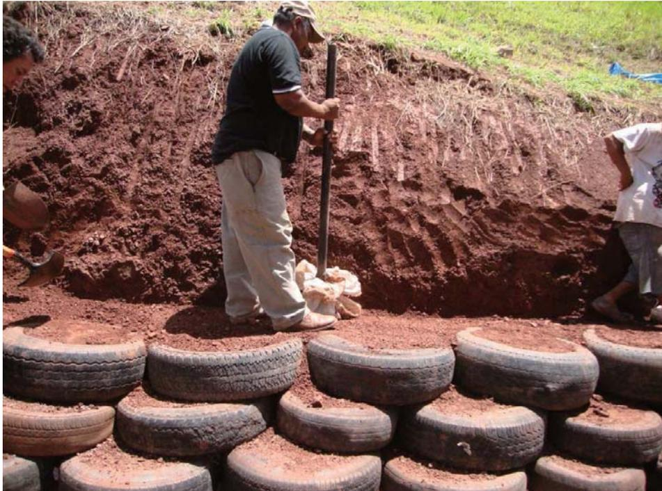
Fotografía.— 7 Compactación de la parte trasera de la obra (en medio de las llantas y la pendiente).
