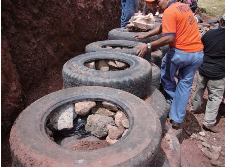
Fotografía.— 5 Trabajos de colocación de rocas dentro de las llantas.
