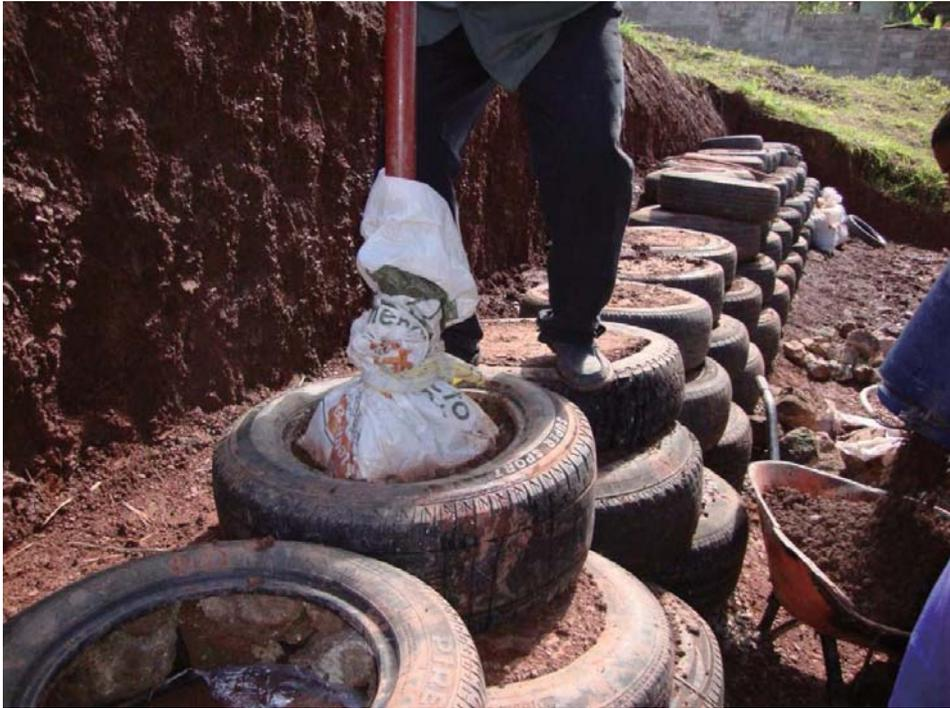
Fotografía.— 6 Compactación de la mezcla de suelo- cemento con una compactadora manual.
