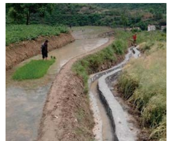
通水が始まった水路 (2014年5月)
