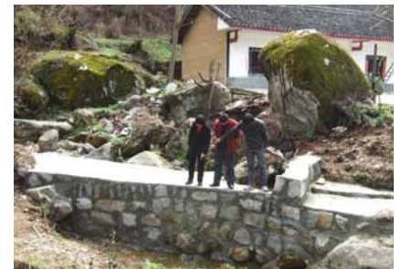
完成した取水堰(2012年3月)
