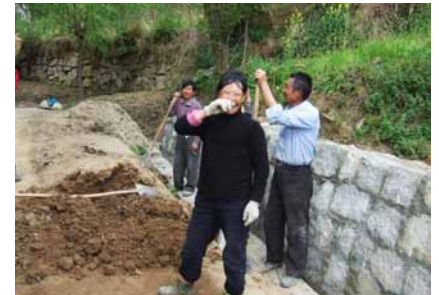
村民の手による用水路の工事
