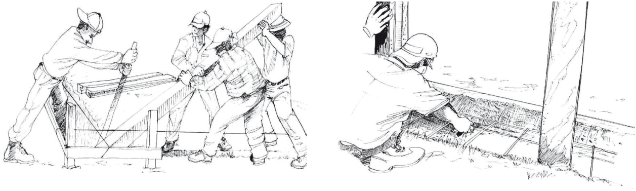
Figura 4.4: colocación de columnas previo a colado de solera
