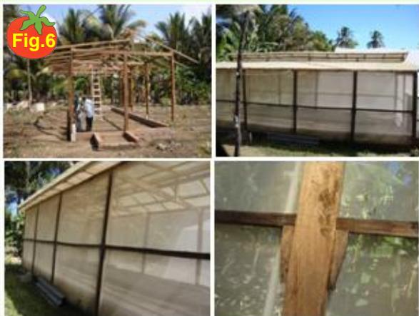
Fig. 6 Monitor caída de agua, reglas pachas sobre las mallas y sapos de soporte
