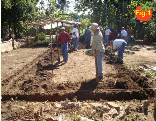
Fig. 1 Trazo y preparación de terreno
