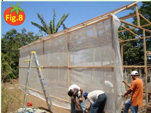
Fig. 8 Clavado de la regla sobre la malla
