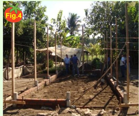
Fig. 4 Nivelación de cuarterones empezando con los zoquetes
