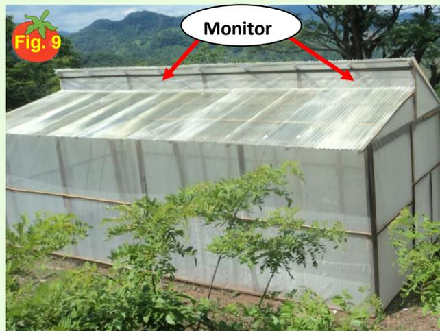
Fig. 9. Vista lateral de monitor
