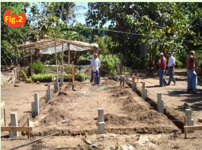
Fig. 2 Colocación de zoquetes en la fundación
