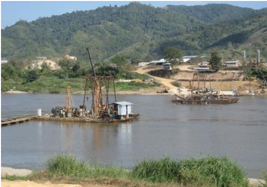
チェンコン郡における橋の建設の様子
