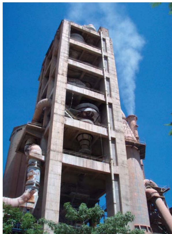
セメント生成過程で放出される蒸気を発電に活用すれば、工場全体の電力消費量の30%が賄える
