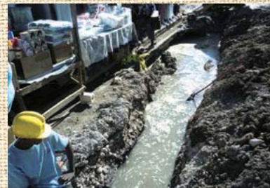
配水管路の整備工事をする作業員
