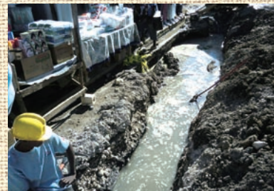
配水管路の整備工事をする作業員
