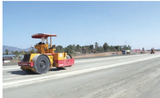
NEDAの有償・無償資金協力によって実施されているラオス南部・バクセー空港の拡張事業
