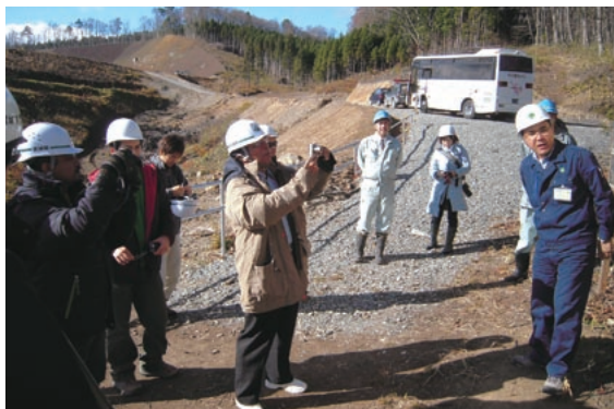
2008年の岩手・宮城内陸地震被災現場である荒砥沢栗原地方ダムを視察。被害状況や現在の復旧についての説明を受けた
