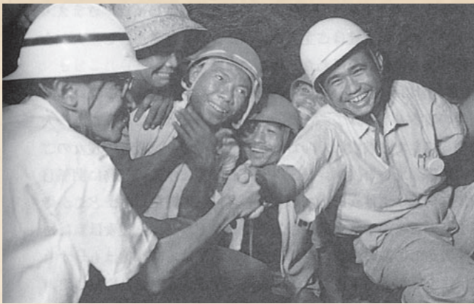
カリコト・ダムの排水トンネルが貫通し、喜ぶインドネシア人の技術者たち
