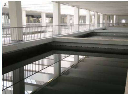
※自動式の急速ろ過装置。
