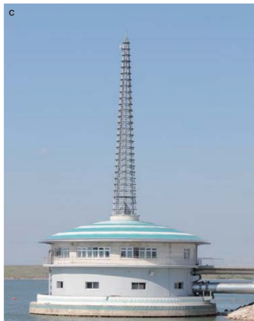
a. 円借款で新設された浄水場。ろ過装置には、荏原製作所の特許技術が使われている b. 新浄水場の制御室。大型パネルで場内の状況がひと目で分かり、異常が発生した箇所は赤く点滅する設定になっている c. 市の中心から約50キロ南東にある貯水池に円借款で建設された取水塔。取水量などのデータは、レーダーで街なかにある浄水場の制御室に送信される仕組みになっている d. アスタナ市水道公社のドゥサイエフ総裁（右）は、日本人コンサルタントと毎週のようにミーティングで顔を合わせており、下藤さんとは腹を割って話せる仲
